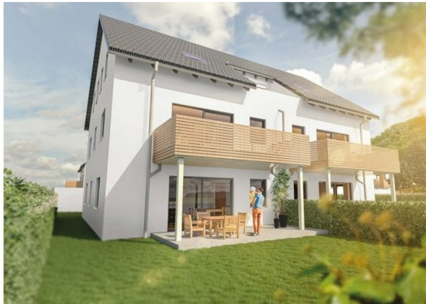
Mehrfamilienhaus in Donaustau
